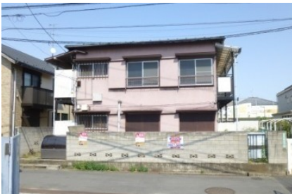
昭和48年築 老朽化し、耐震にも不安のあるアパート
