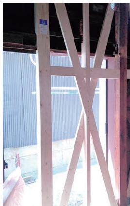
斜めに入れた筋交い(右)と柱・梁・筋交いを耐震金物で固定し(上)補強することで耐震性をアップ
